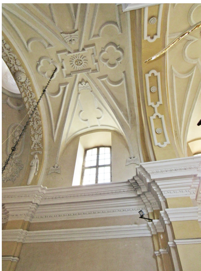
Widok na sklepienie przęsła
