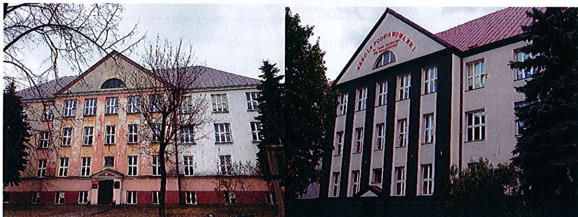
fot. stan sprzed termomodernizacji
