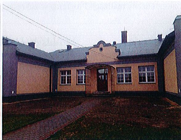
fot. stan po termomodernizacji
