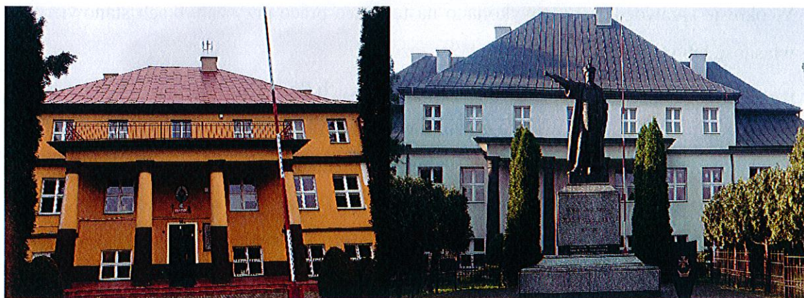
fot. stan sprzed termomodernizacji
