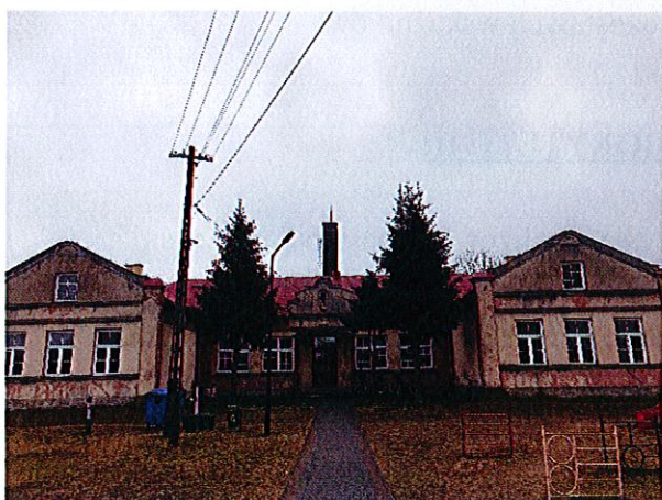
fot. stan sprzed termomodernizacji
