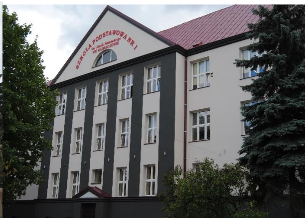
fot. stan po termomodernizacji
