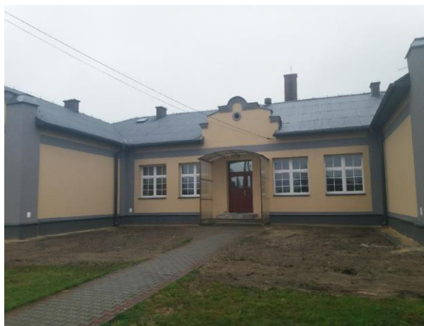
fot. stan po termomodernizacji
