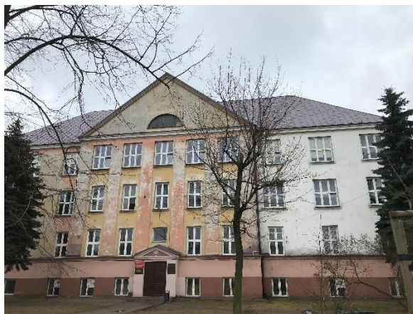
fot. stan sprzed termomodernizacji
