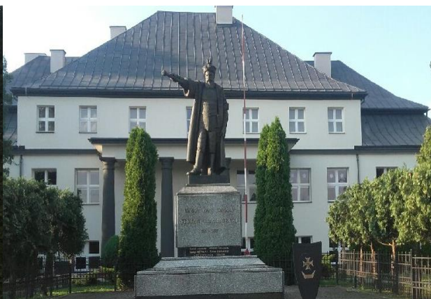
fot. stan po termomodernizacji
