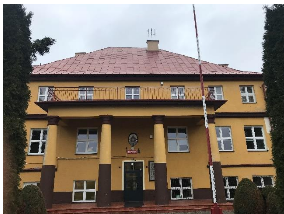
fot. stan sprzed termomodernizacji
