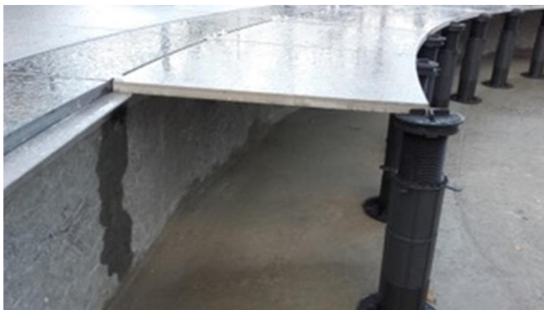
Fontanna z płyt ceramicznych na wspornikach (dla wzmocnienia płyty należy podkleić siatką)
